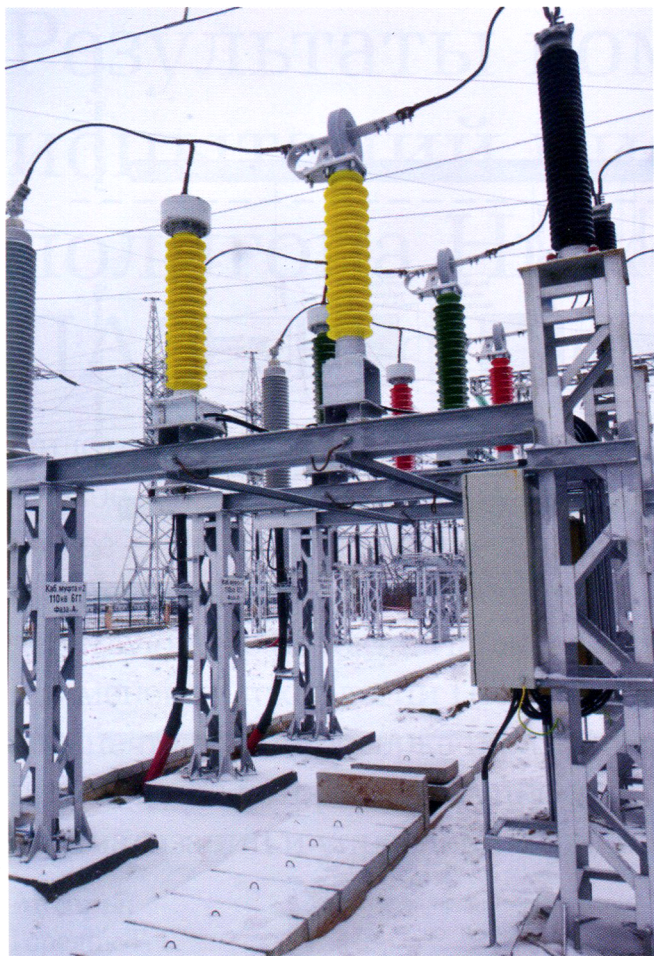
Рис. 2. OTT и OTN 110 кВ
